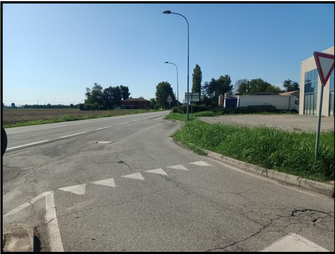
Vista SP18 – Via dei Pioppi
