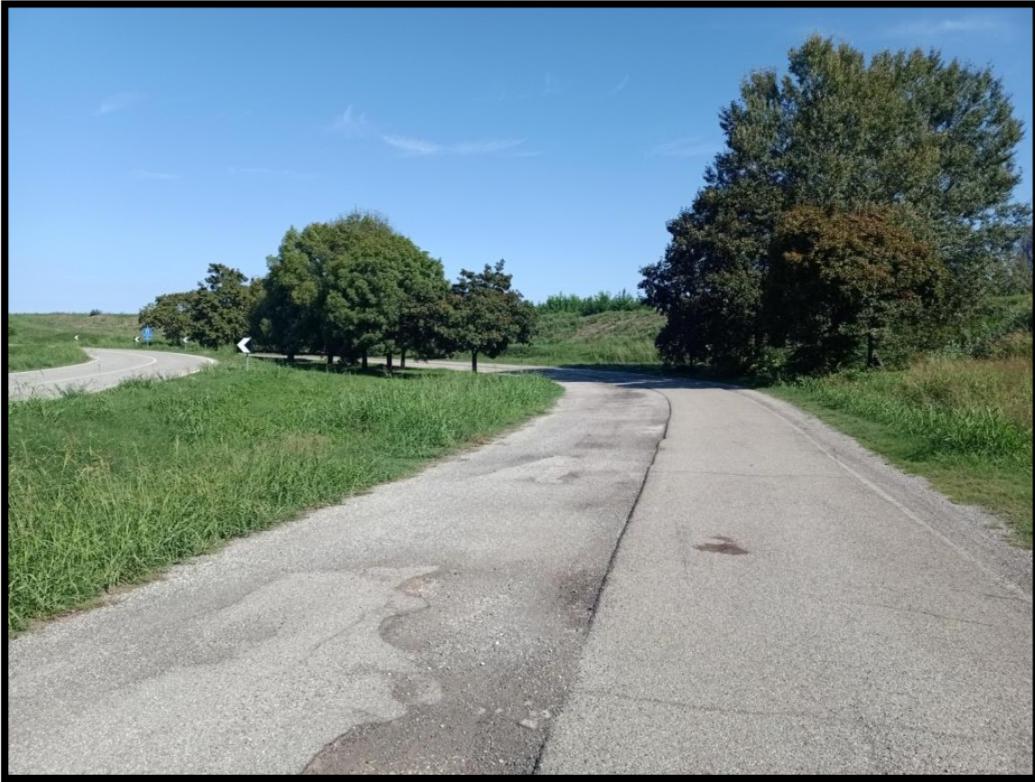
Vista SP 18 – Tratto vecchia sede stradale in disuso
