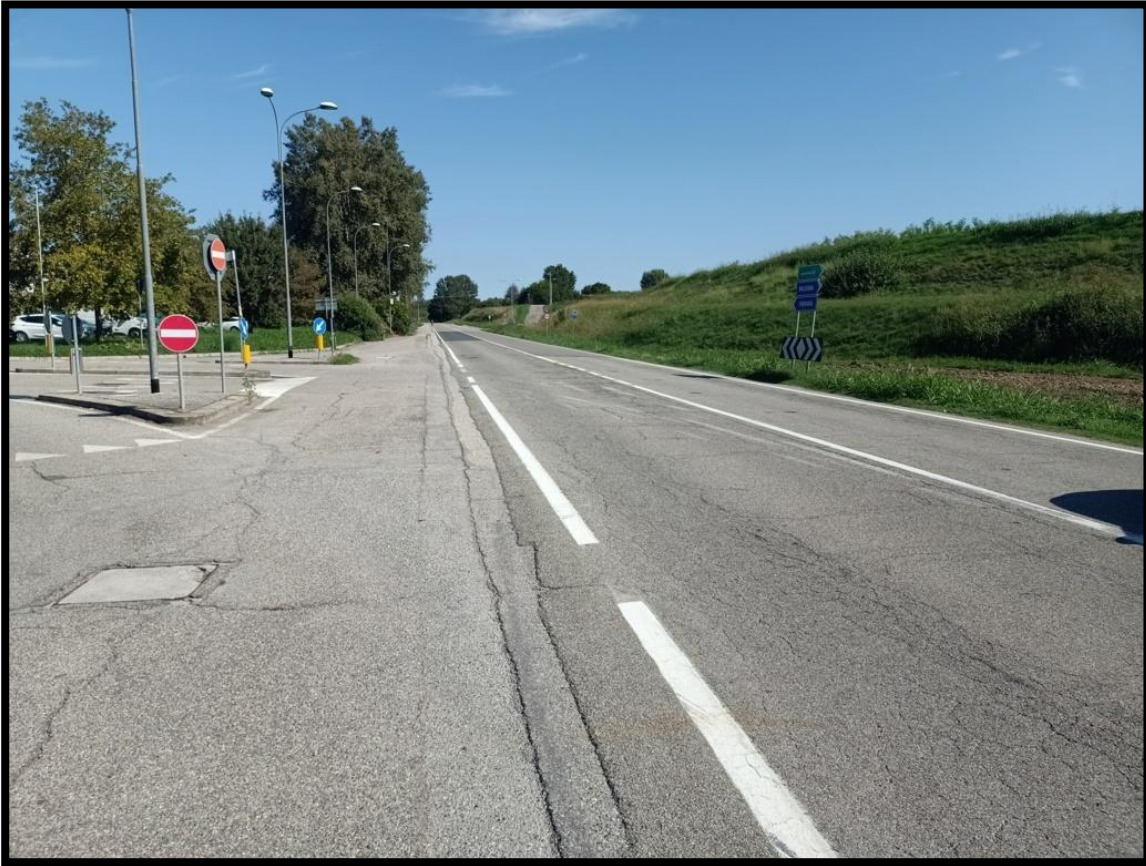
Vista SP18 – Via dei Pioppi
