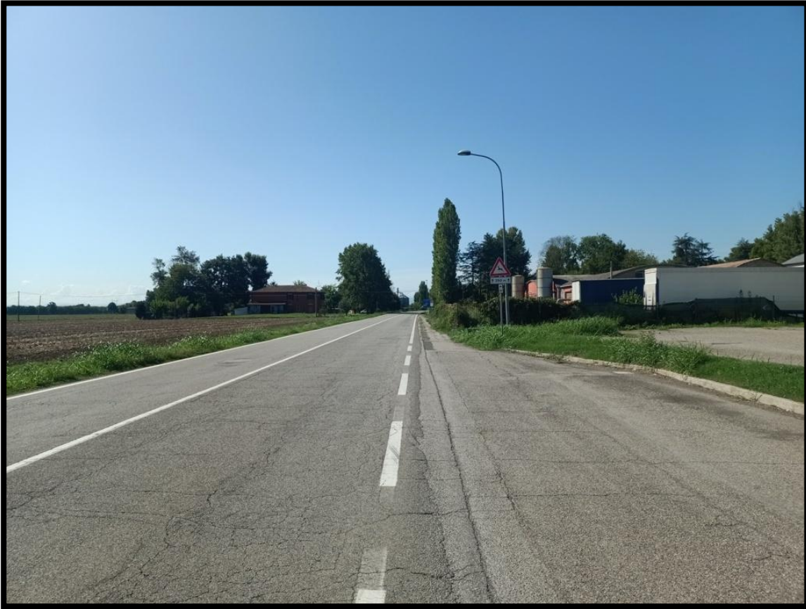
Vista SP18 – Via dei Pioppi
