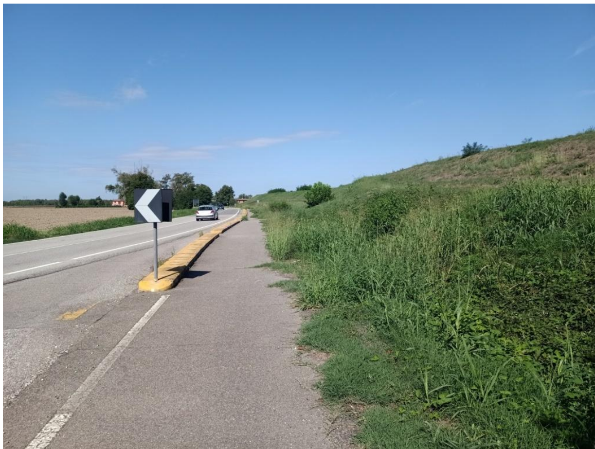
Vista del tratto di pista ciclabile esistente a margine della SP18
