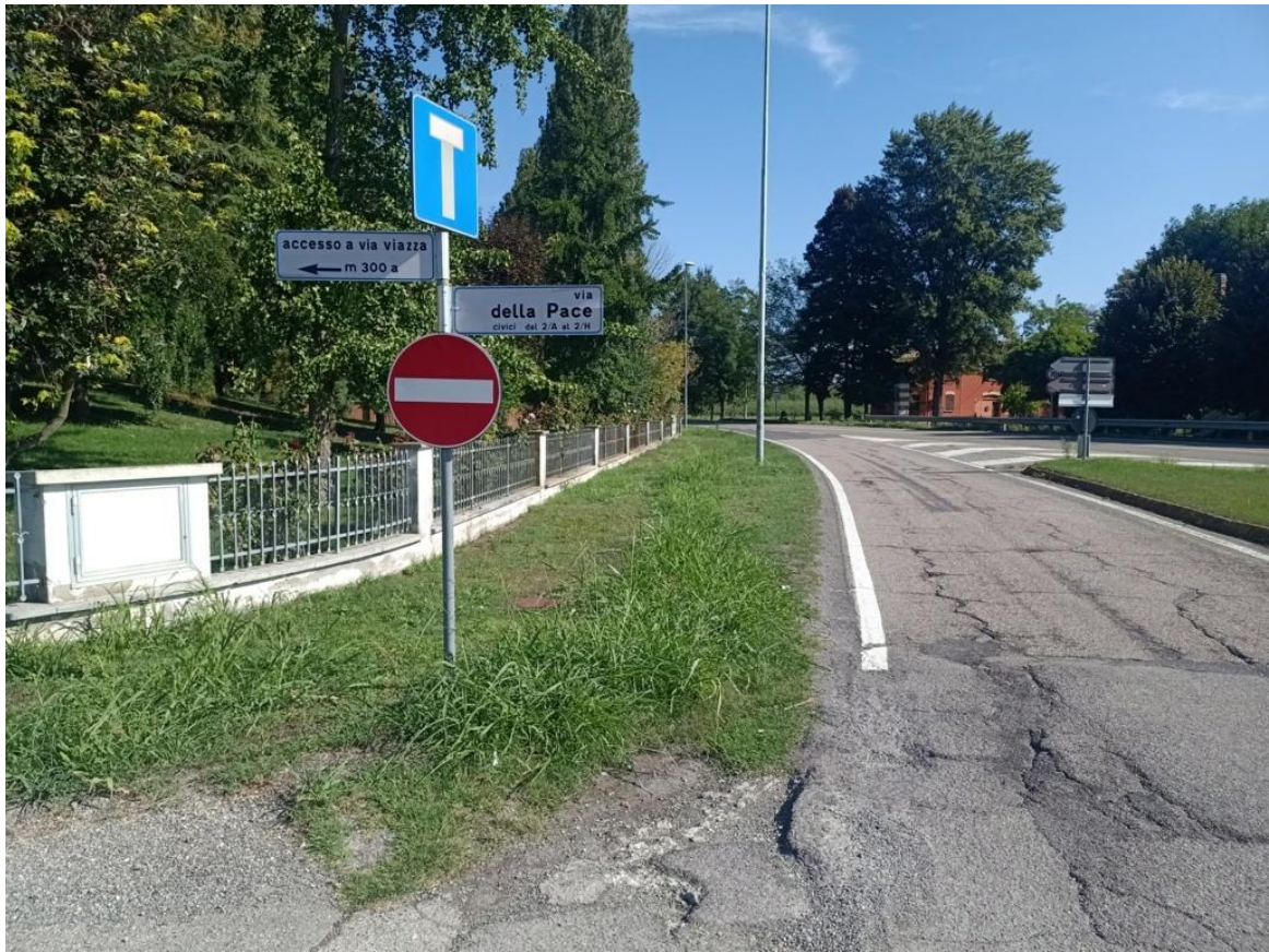
Tratto in corrispondenza dell'incrocio fra Via della Pace e la SP18
