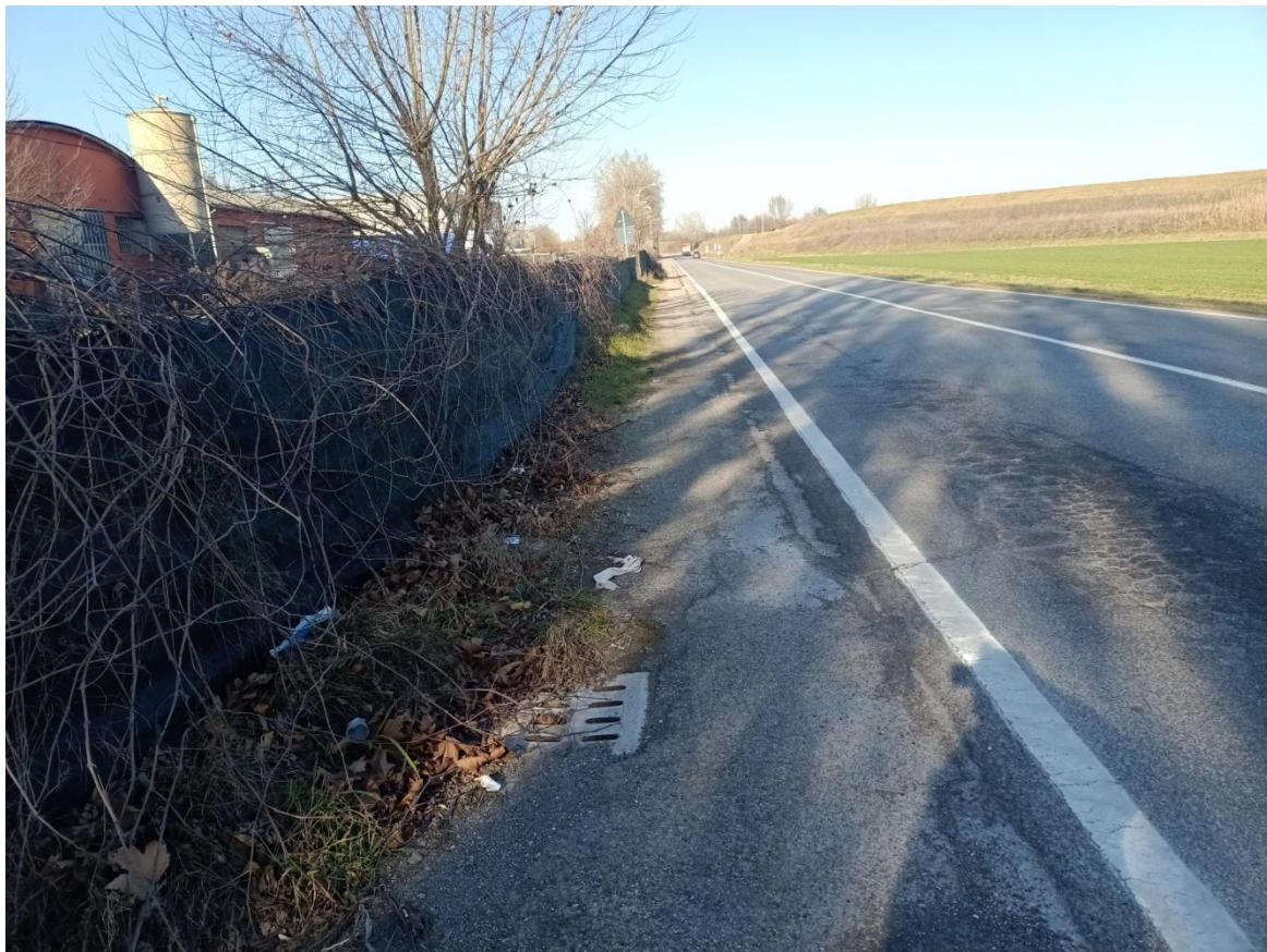
Tratto in corrispondenza della SP18 (tratto oggetto di allargamento)
