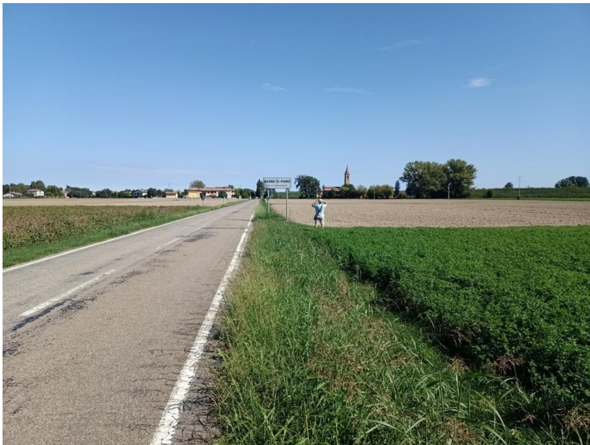
Vista del tratto interessato dalla realizzazione del nuovo tratto di pista ciclabile
