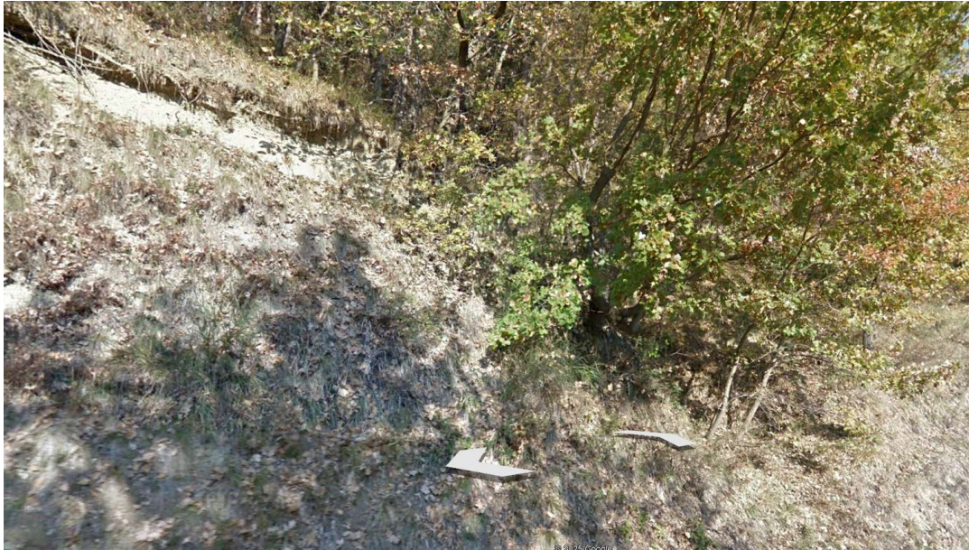
Figura 8bis: Vista della scarpata di monte alla progressiva km 1+800, prima della colata di frana.
