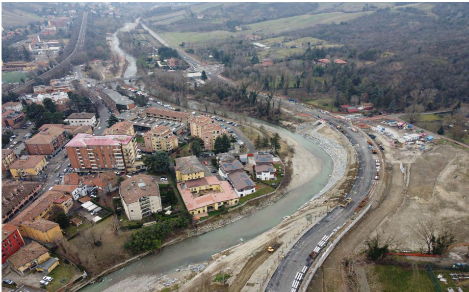
Foto da drone: zona Via Torriane, Ponte delle Oche
