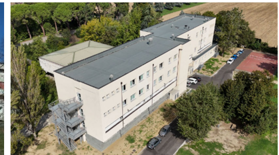
Foto esterne a lavori conclusi
