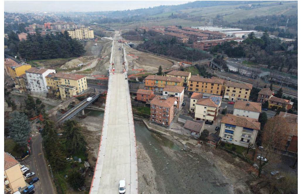
Foto da drone: zona Viadotto Savena, Galleria Ferroviaria
