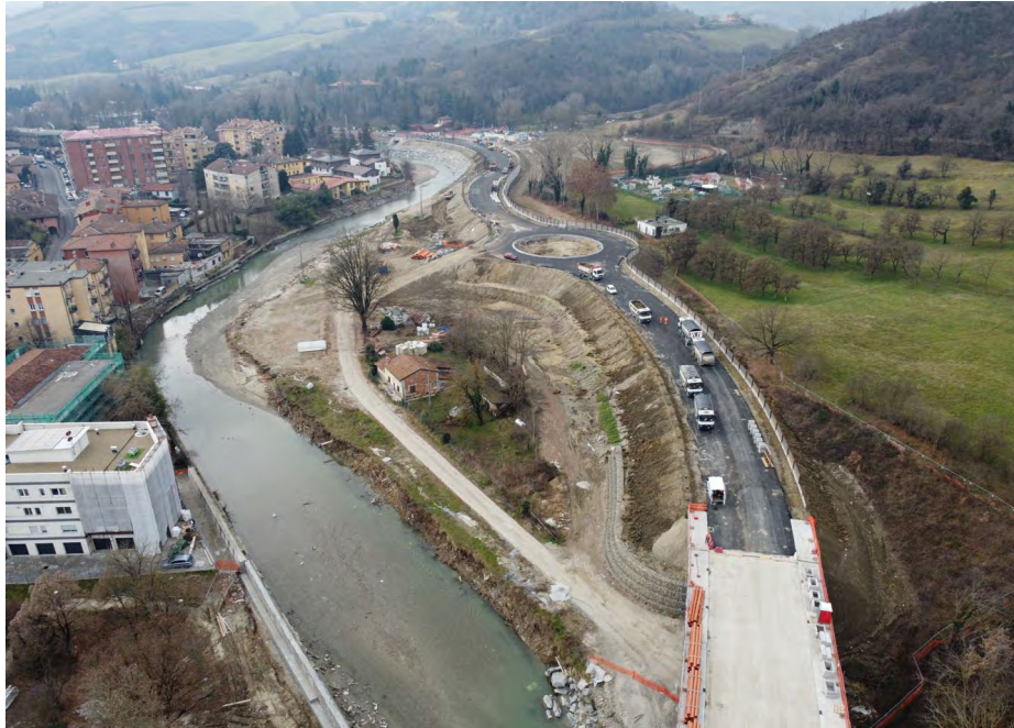
Foto da drone: zona Viadotto Savena, rotatoria Paleotto, Via Torriane
