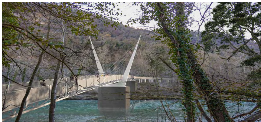
Passerella sul fiume Reno
