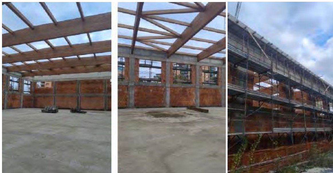
Foto dei lavori effettuati fino al mese di Dicembre 2024 (stato di avanzamento lavori 55%)
