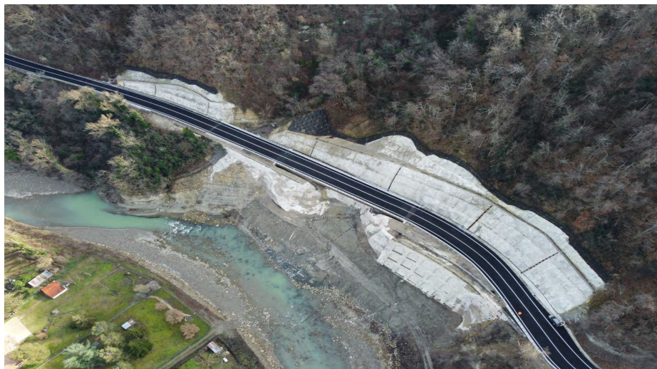
STATO DI FATTO (vista dall'alto)
