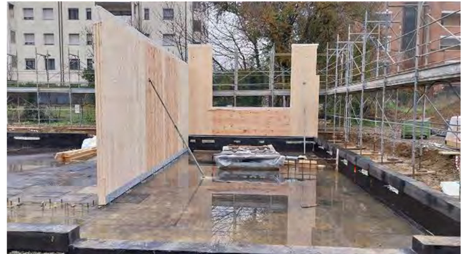
Foto di dicembre 2024 (stato avanzamento lavori 20% circa)
