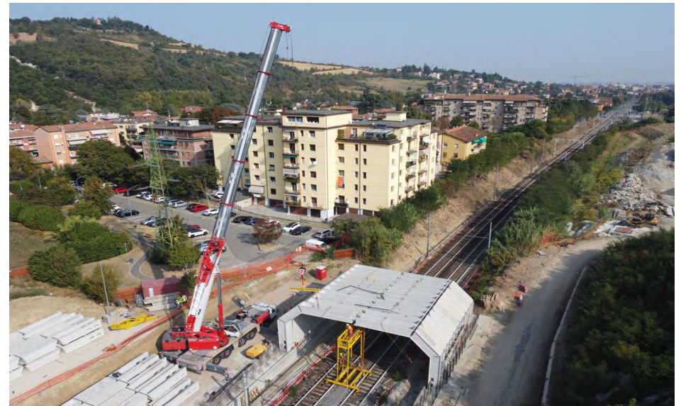
Foto da drone: Galleria Ferroviaria in fase di realizzazione
