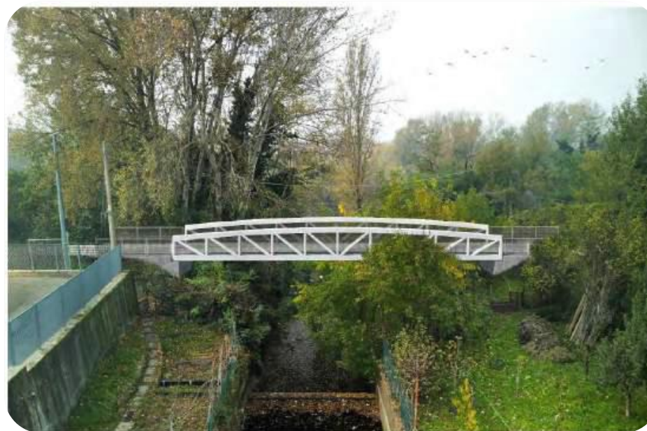
Passerella collettore fiume Reno
