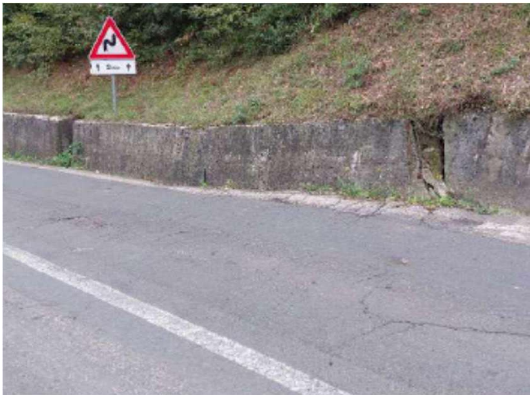
Fig. 2 – Foto dettaglio intervento n°3.
