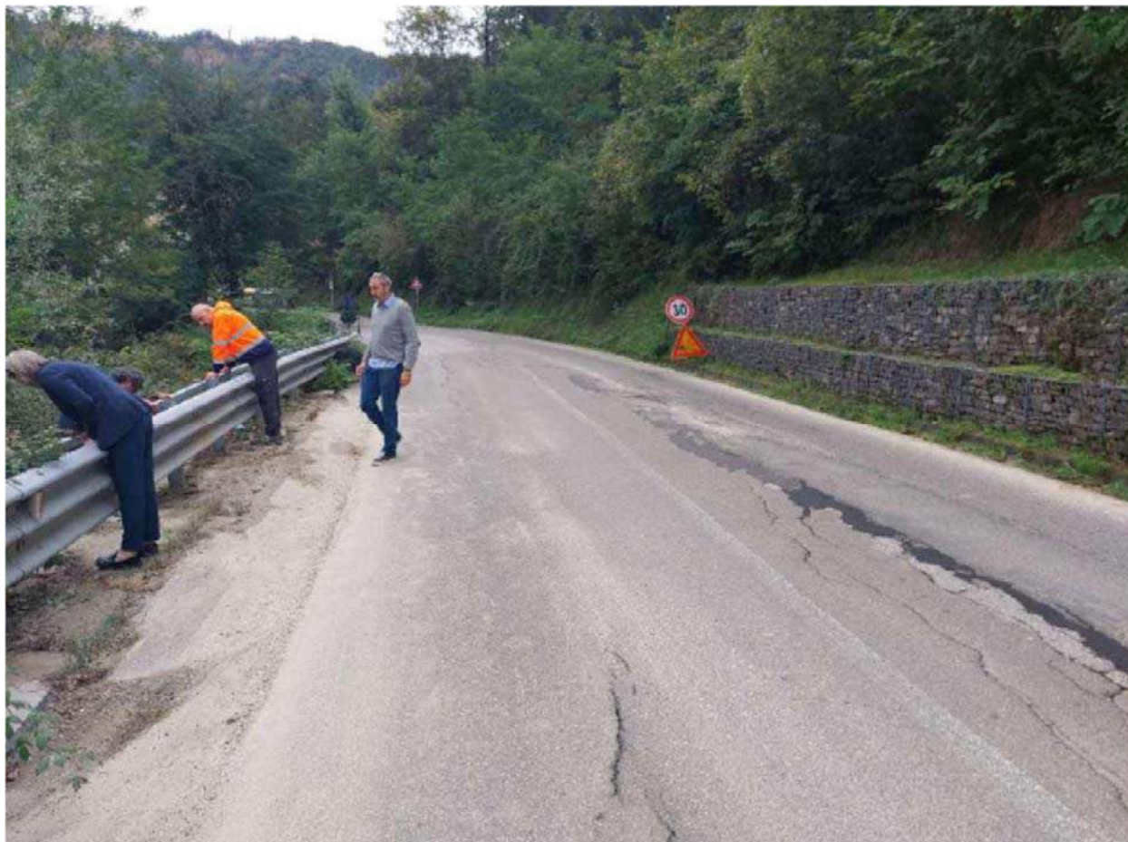
Fig. 2 – Foto dettaglio intervento n°10.
