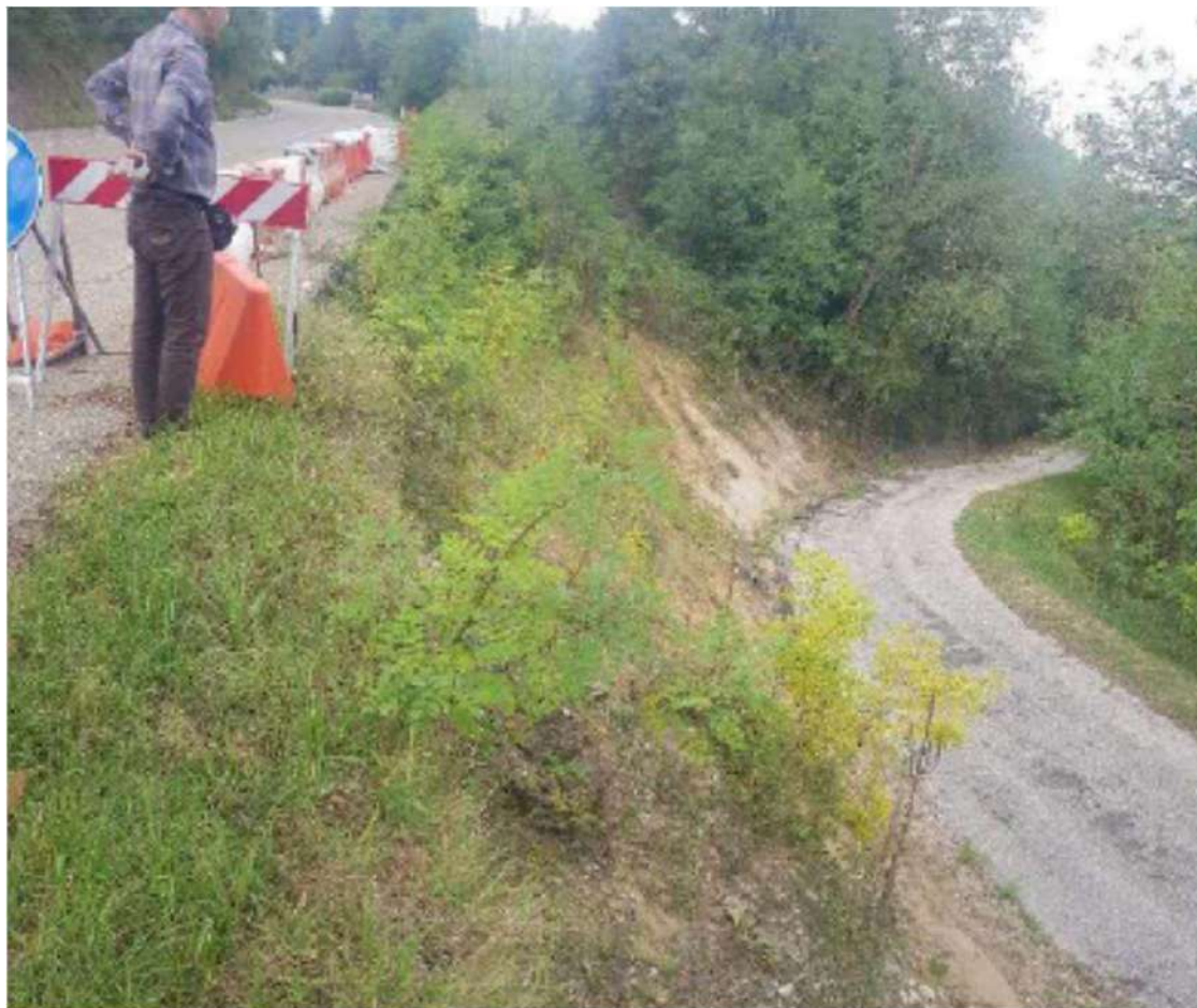
Fig. 2 – Foto dettaglio intervento n°7.
