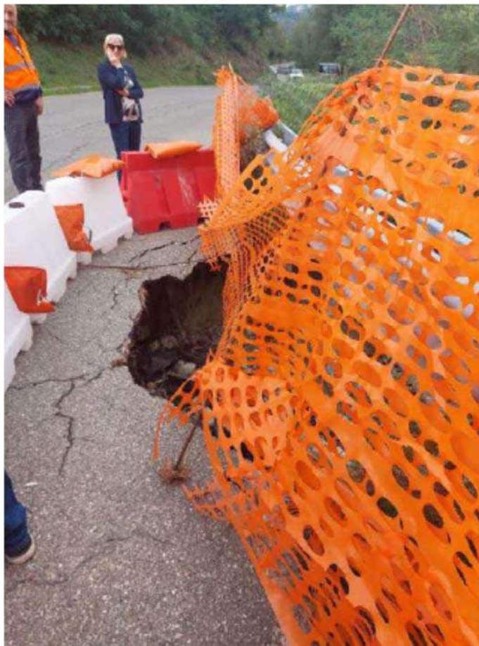
Fig. 2 – Foto dettaglio intervento n°6.
