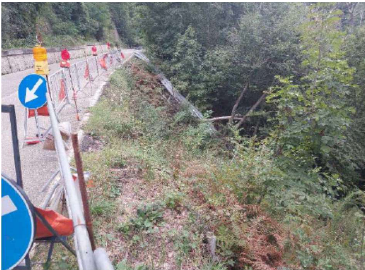
Fig. 2 – Foto dettaglio intervento n°9.
