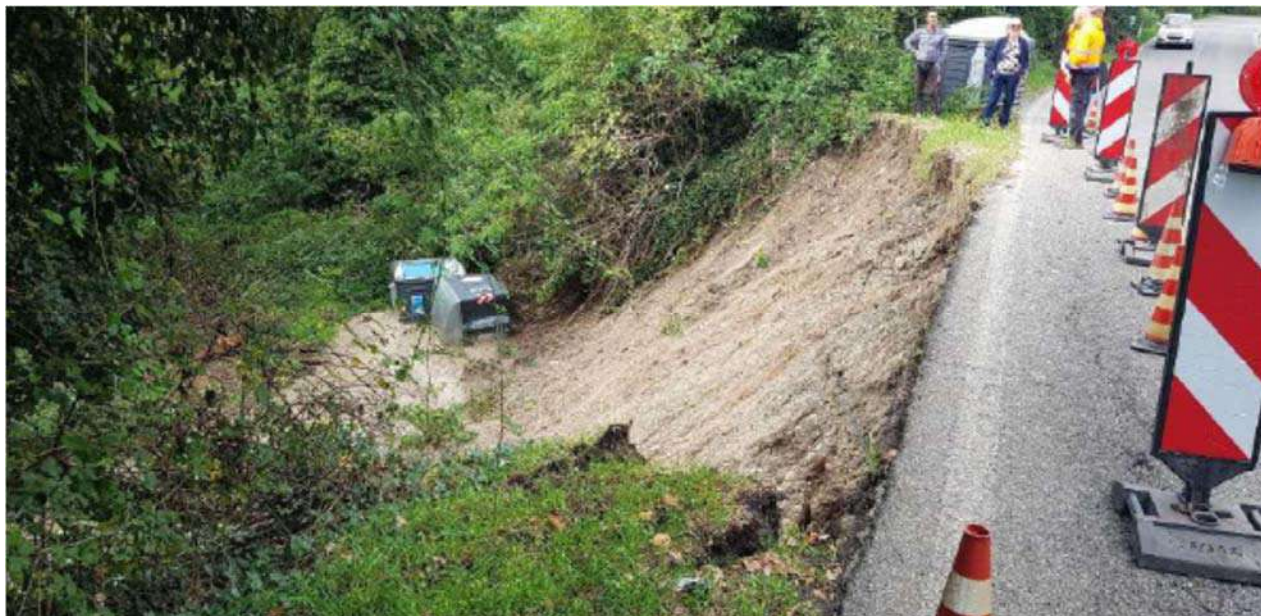
Fig. 2 – Foto dettaglio intervento n°4.
