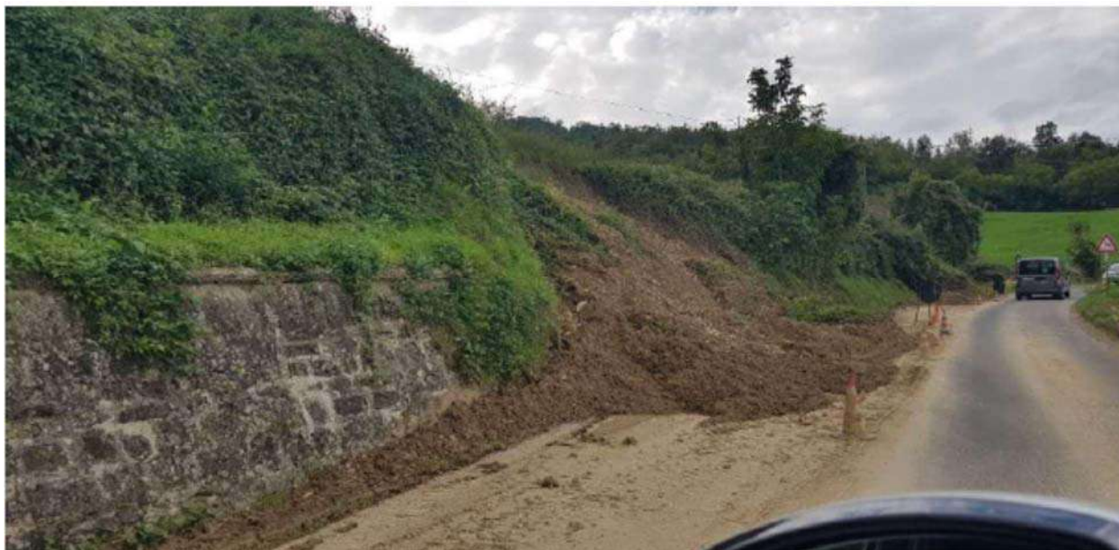
Fig. 2 – Foto dettaglio intervento n°2.
