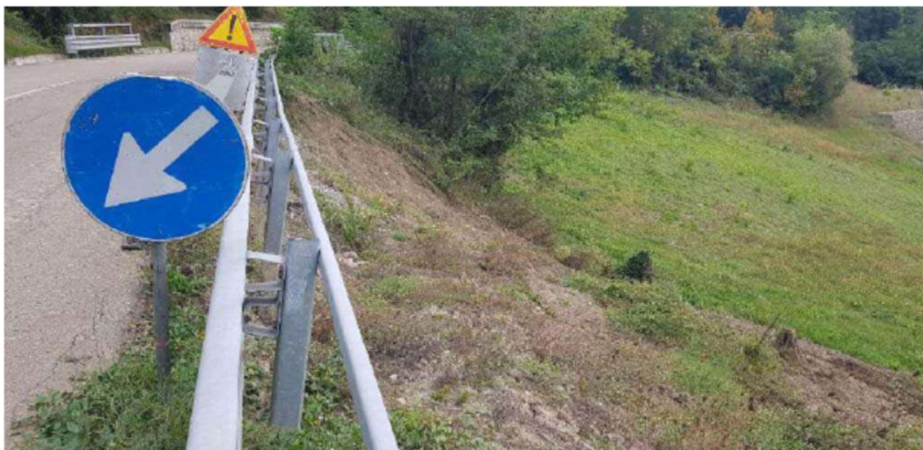
Fig. 2 – Foto dettaglio intervento n°11.
