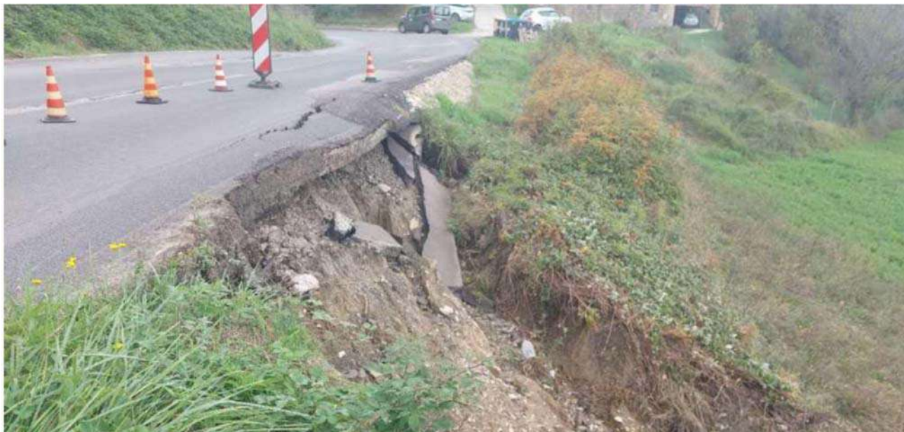
Fig. 2 – Foto dettaglio intervento n°1.
