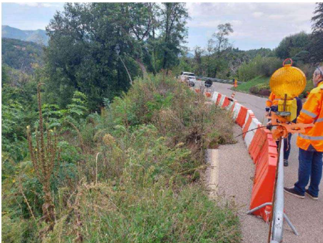
Fig. 2 – Foto dettaglio intervento n°5.
