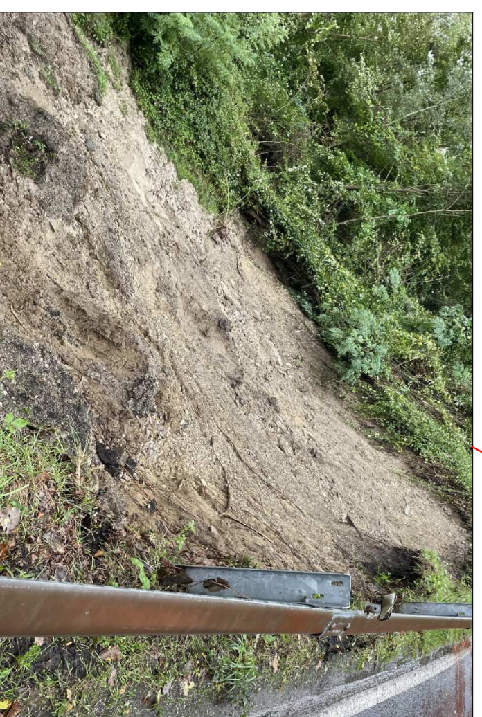
INTERVENTO "BISANO 6" ANTE INTERVENTO
